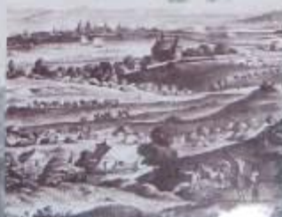
Belagerung bei Mainz 1793
